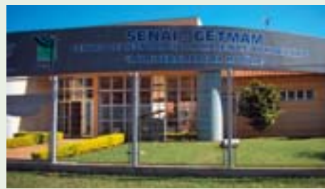
Das Technologiecenter des Holzes und des Möbels (CETMAM) in Arapongas im Bundesstaat Paraná in Brasilien
